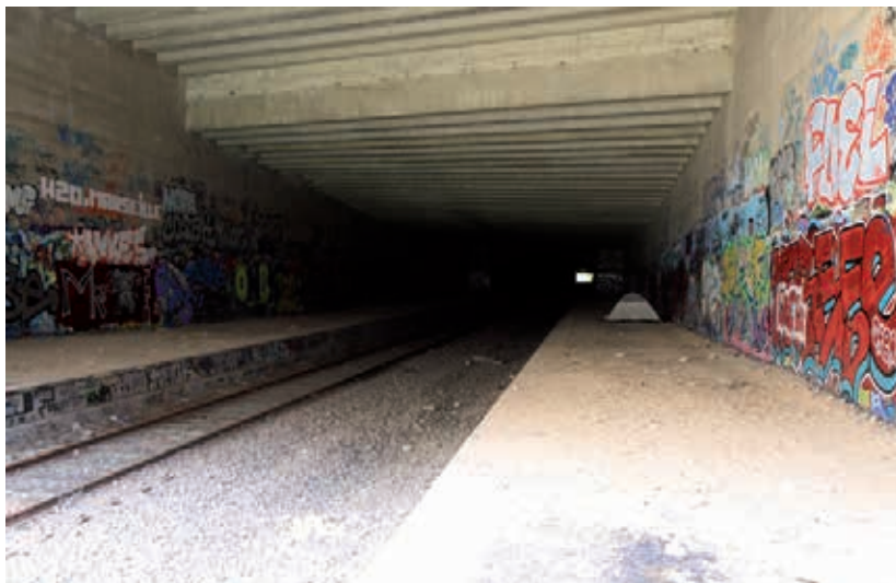
Sous la dalle Broussais (vue vers la rue Didot), 14 e arr.
