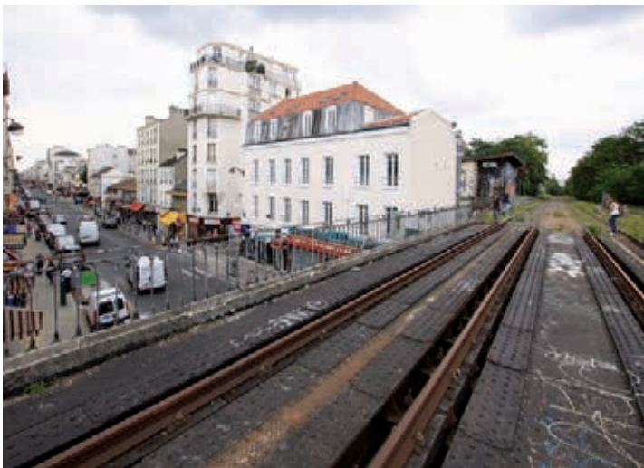
Franchissement de la rue d'Avron, 20 e arr.
