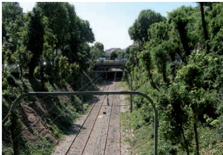
La Tranchée Pereire depuis la place Wagram, 17 e arr.
