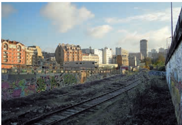
La Petite Ceinture au droit de la Zac de Rungis, rue des longues Raies, 13 e arr.
