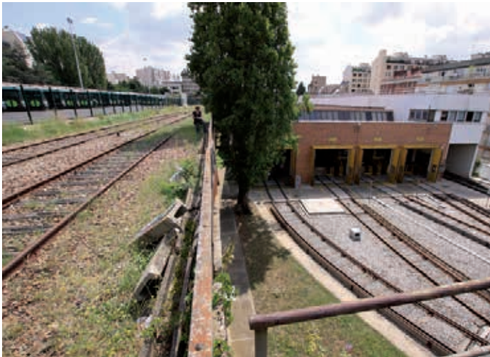
Les ateliers de maintenance de la ligne 1 du métro, 20 e arr.
