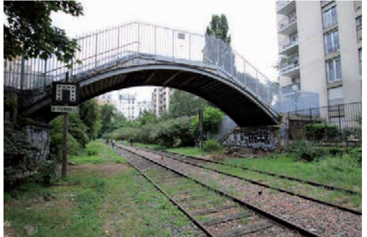
Passerelle rue de la Mare (ouvrage classé), 20 e arr.
