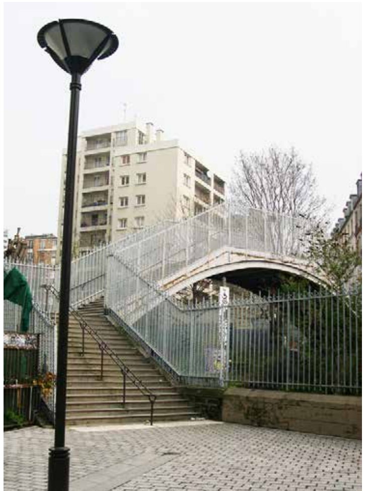
Accès à la passerelle de puis l'espace public, 20 e arr.
