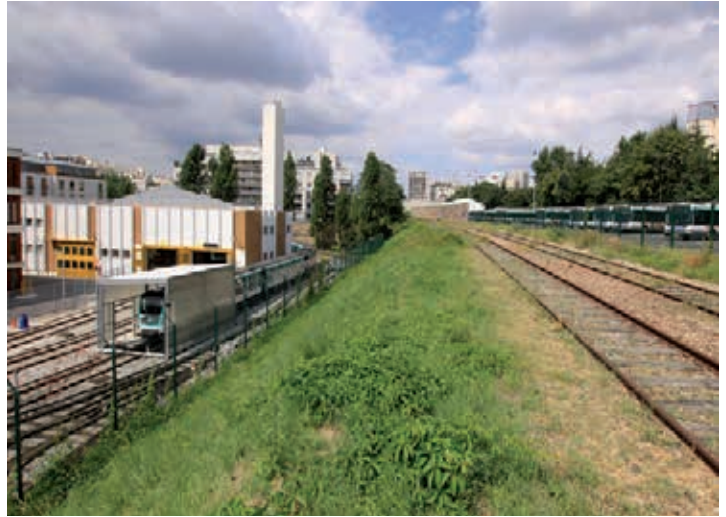
Le long du centre de maintenance de la ligne 1 du métro, rue de Lagny, 20 e arr.
