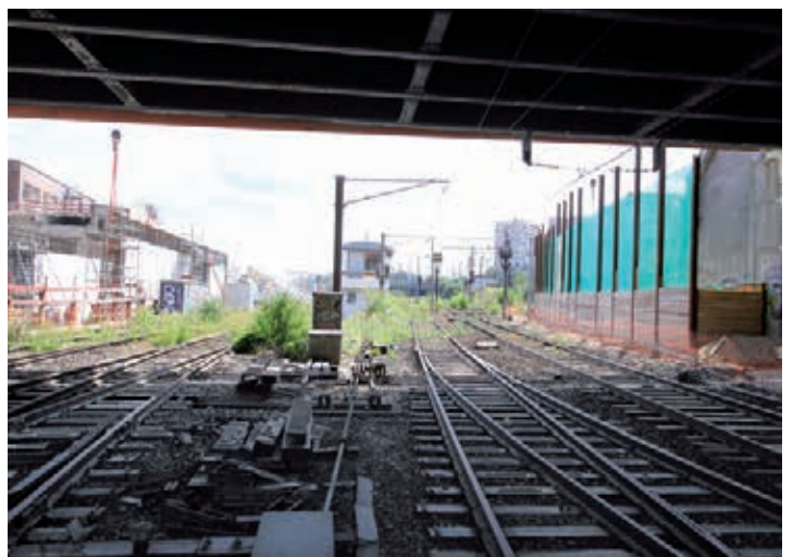
Faisceau vue vers l'Est sous la rue d'Aubervilliers, 19 e arr.
