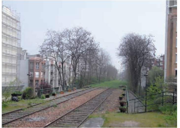
Franchissement de la rue de la rue Claude-Decaen,12 e arr.
