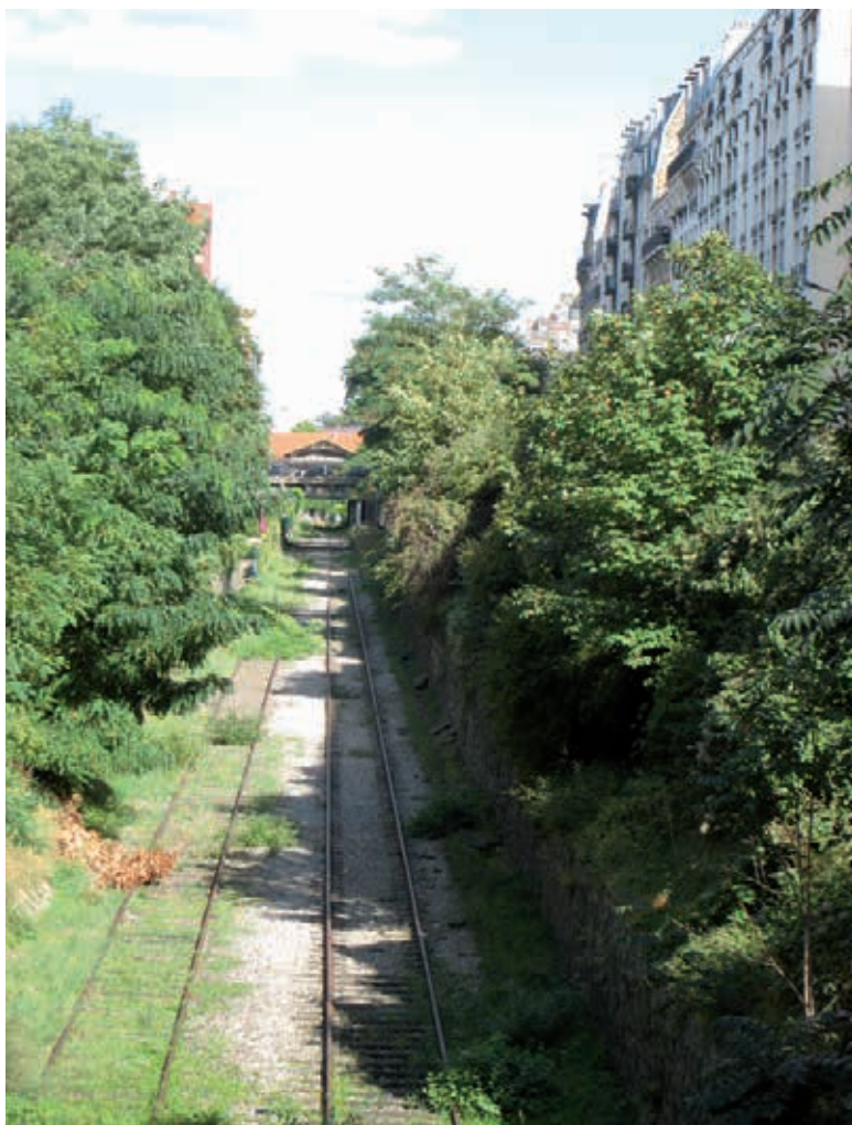
La Petite Ceinture au niveau de la rue du Poteau, la gare de Saint-Ouen au loin, 17 e arr.
