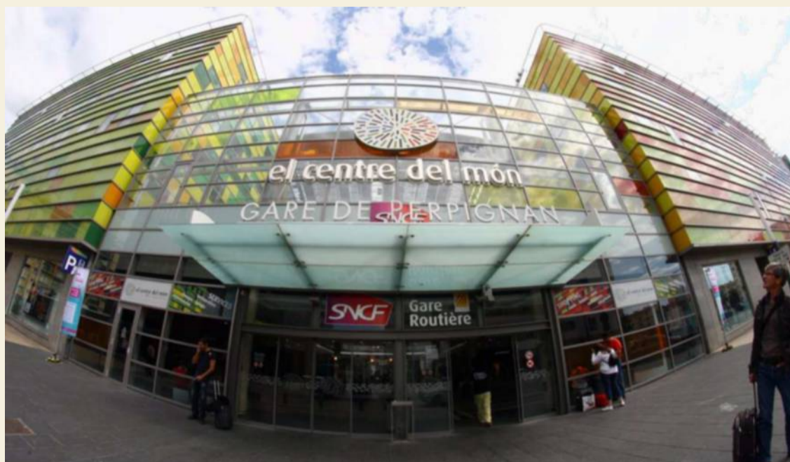
Perpignan (Pyrénées-Orientales), le 16 septembre. Cette structure colorée abrite la gare mais aussi 22 000 m 2 de commerces et de bureaux. (PhotoPQR/« l'Indépendant » / Michel Clementz.)
