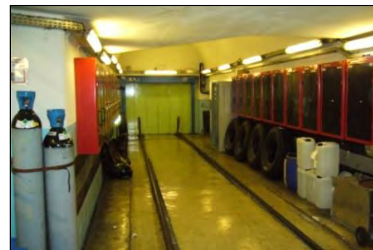
L'accès intérieur au monte-charge
