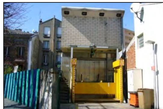
L'accès extérieur au monte-charge
