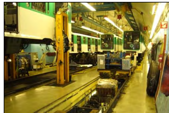
Les voies de maintenance et la position de levage
