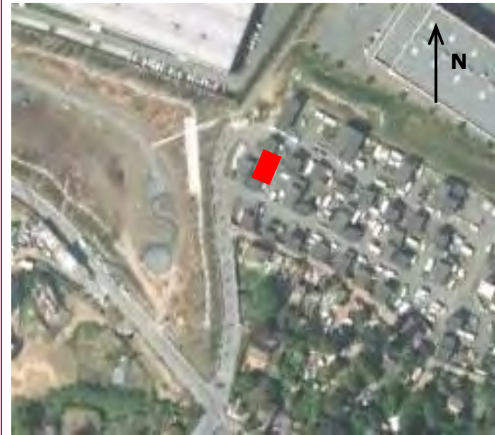
8. Londeau - Poste de redressement
