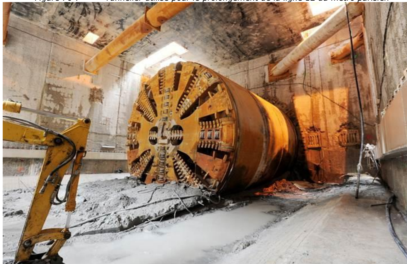
Figure 70 : Tunnelier utilisé pour le prolongement de la ligne 12 du métro parisien
