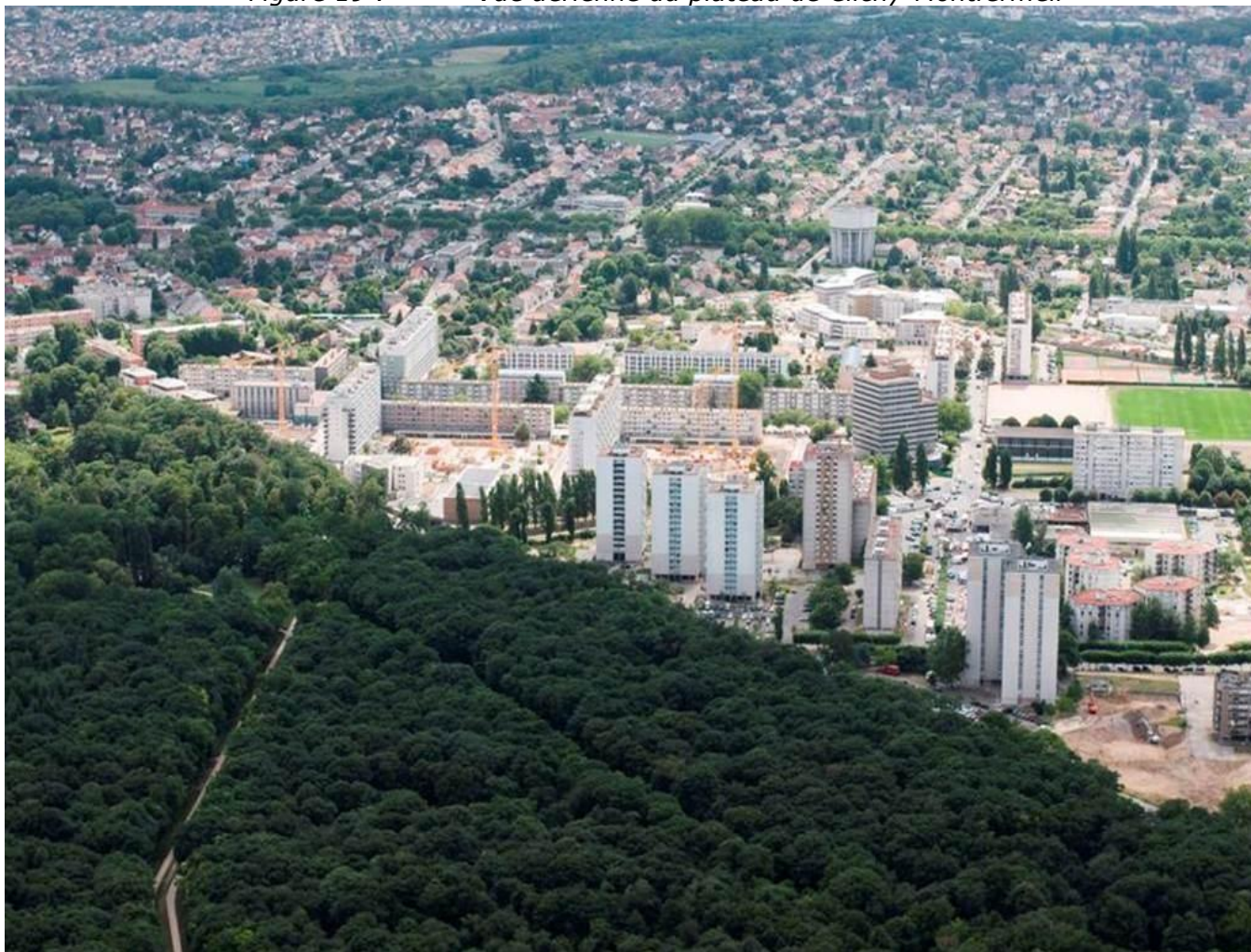
Figure 19 : Vue aérienne du plateau de Clichy-Montfermeil
