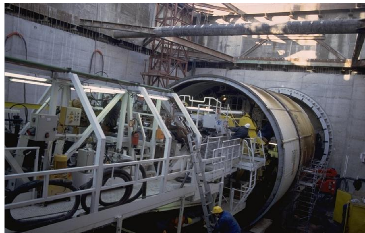
Figure 33 : Métro Val de Rennes – Entrée du tunnelier
