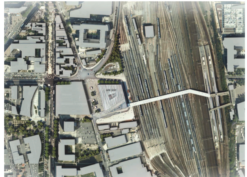
Figure 93 : Implantation de la station Saint-Denis-Pleyel sur photo aérienne (extrait EP L16/17) (Source : SGP)
