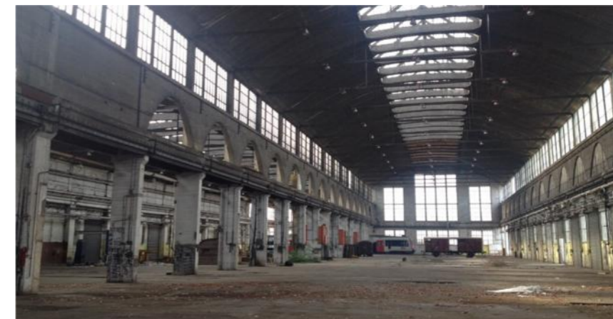
Figure 195 : Halle SNCF qui fera l'objet d'une réhabilitation. VPA 28/11/2014
