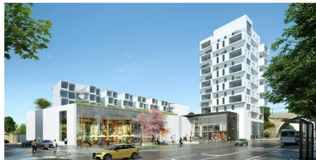
Figure 62 : Vue depuis la ville (RA, déc. 2014)
