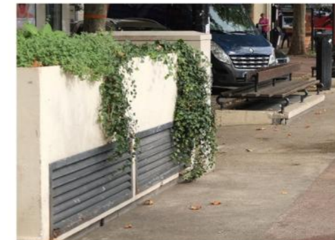
Emergences techniques du parking, Parvis de Saint-Maur
