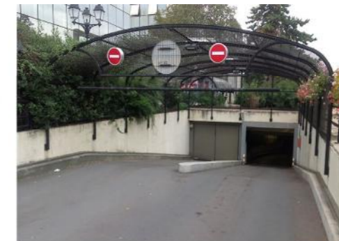
Sortie parking, rue des Remises
