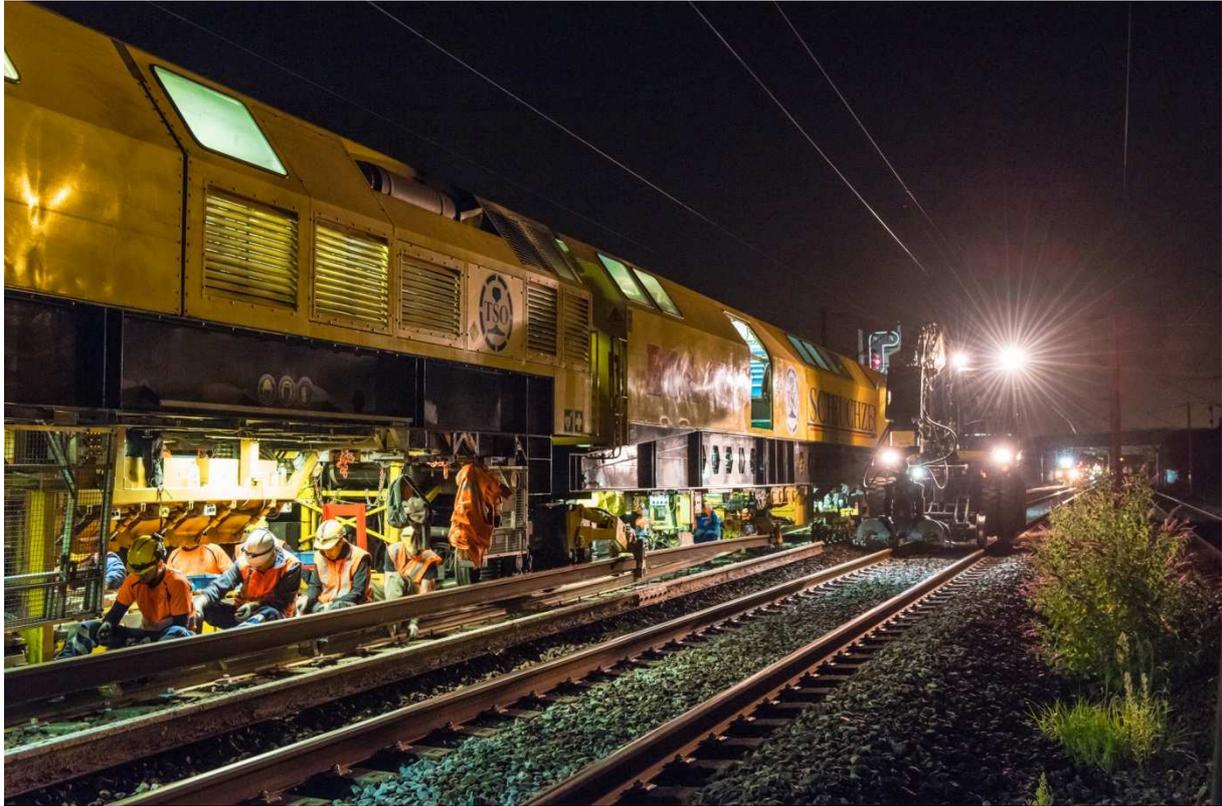
*Le train BOA permet de décharger des rails de 80 à 120 m venant directement des aciéries, de les souder électriquement en voie, de les substituer aux rails anciens et enfin de recharger les rails remplacés.*
