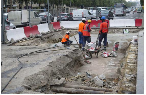
Avenue des Champs-Elysées (VIIIe), jeudi. A la station George-V, les ouvriers ont déterré la dalle de béton. Ils doivent maintenant y appliquer un rouleau bitumineux qui assure l'étanchéité de l'ouvrage pour les 50 prochaines années. (LP/E.L.M.)
