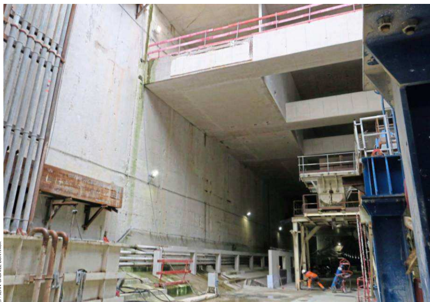
Les grands chantiers, comme ici la construction du prolongement de la ligne 14 du métro, dopent l'activité économique.
